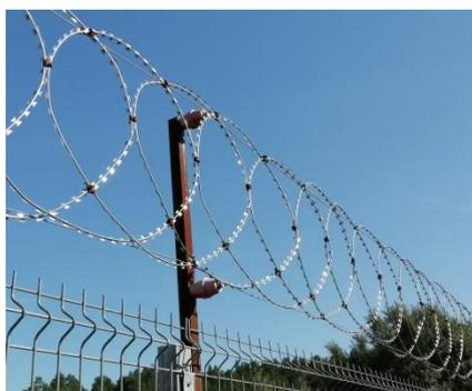
Ограждения дополнительные реализованы в виде много рубежных систем включающих в себя элементы физической защиты. Ограждения являются дополнительным верхним ограждением в соответствии с ГОСТ Р 52860-2007 в комплекте с реализованной системой электрошоковой защиты «АКЛ-ЕГОЗА». Тип «ОД» имеет элемент физической защиты который электризуется системой «АКЛ-
