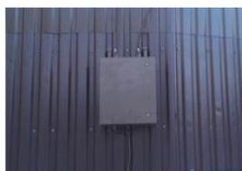
ЗЭШУ «БСКА-001» является основным элементом системы «АКЛ-ЕГОЗА». Предназначен для преобразования электрического тока ~ 220В, 50Гц в импульсный ток напряжением 20кВ, передаваемый на электризуемые элементы. Максимальная длина электризуемого элемента такого как «ЕГОЗА-500» подключаемого к ЗЭШУ «БСКА-001» составляет
